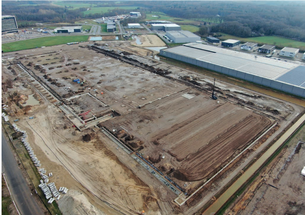
De Aldi in aanbouw op het A1 bedrijvenpark Deventer
